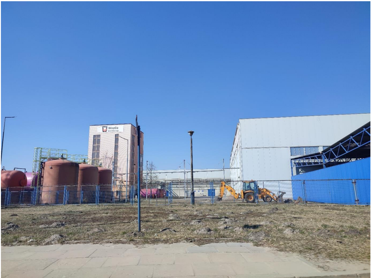
Fotografia 5. Widok na obiekty przedsiębiorstwa Drumet Liny i Druty Sp. z o.o. (od strony ul. Zielnej)
