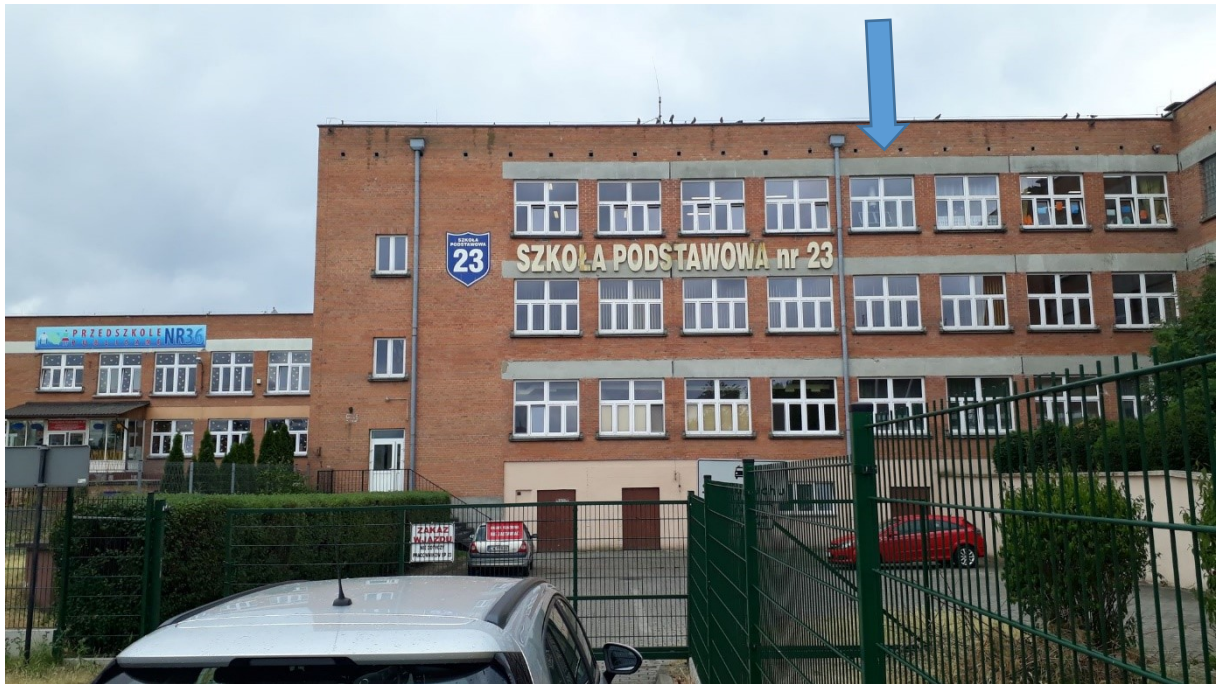
Rys. 4 Miejsce montażu SELMS PEM – Szkoła Podstawowa Nr 23 we Włocławku – widok z poziomu gruntu
