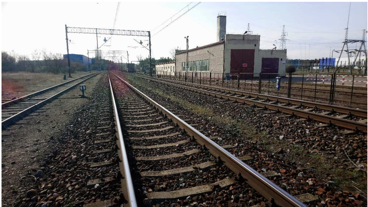
Rysunek 3 Przykładowe zdjęcie fragmentu analizowanej linii kolejowej
