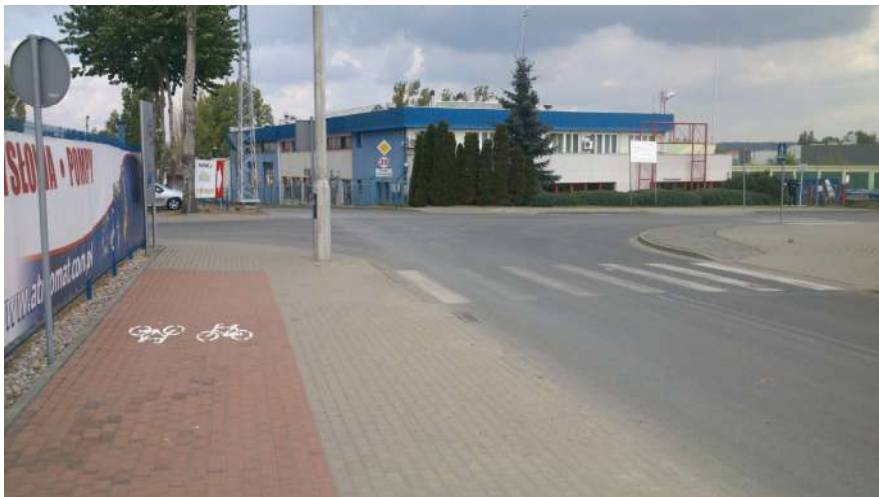
Foto. nr 6 Przykład braku ciągłości ścieżki rowerowej – ul. Cmentarna, Włocławek; źródło: opracowanie własne
