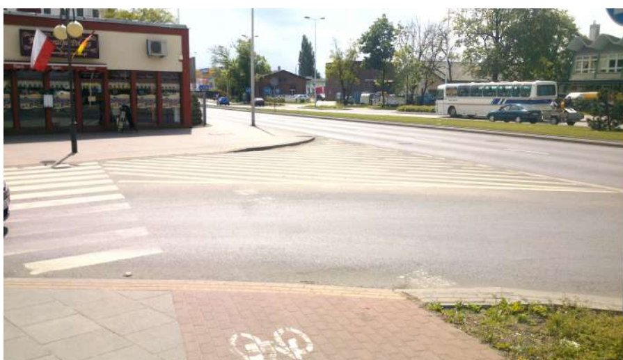
Foto. nr 7 Przykład braku ciągłości ścieżki rowerowej – ul. Okrzei, Włocławek; źródło: opracowanie własne
